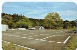
夢の森 職員駐車場をアスファルトに施工しました。
